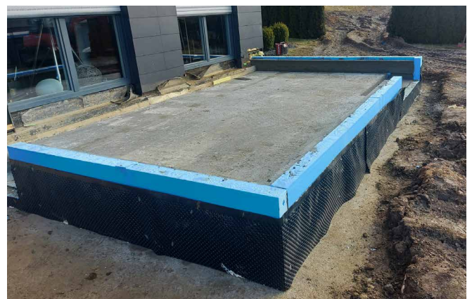
Fundament für Anbau
