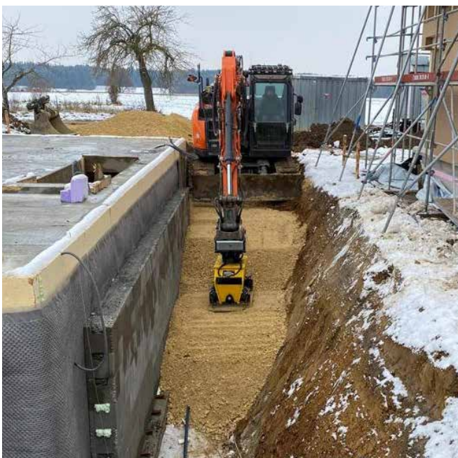
Verfüllen Arbeitsraum
