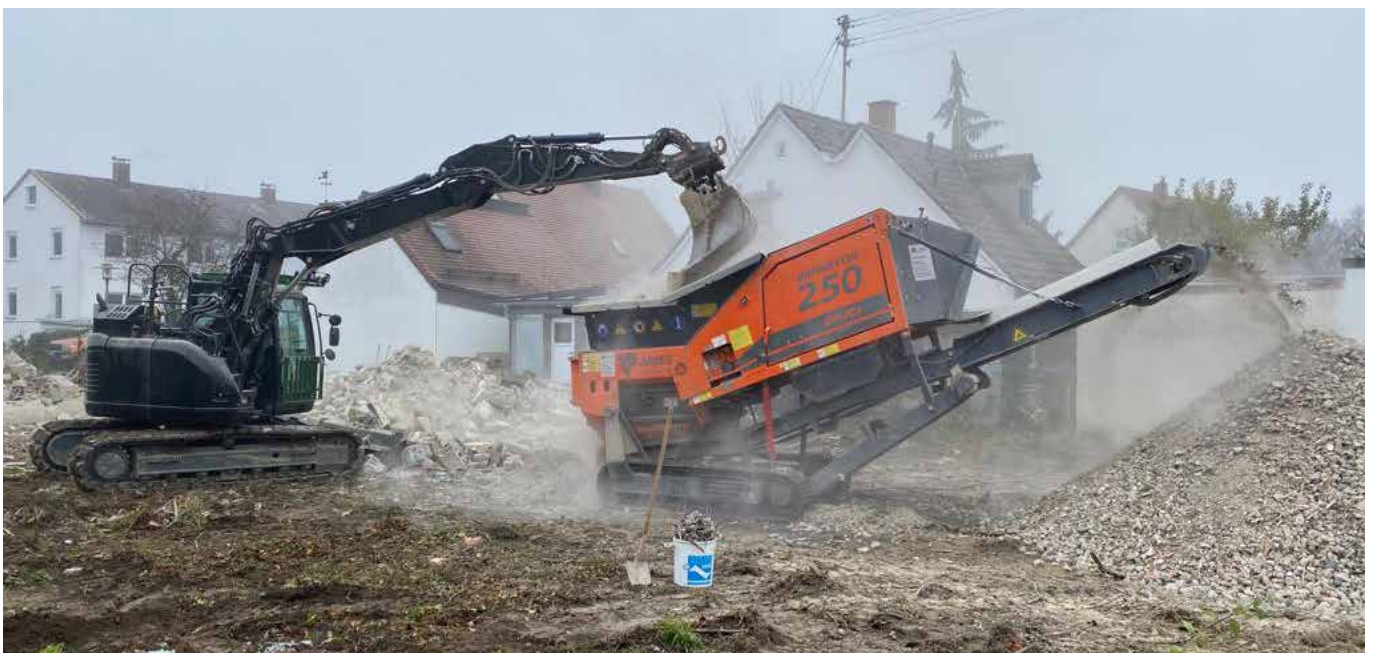
Aufbereitung Recyclingmaterial
