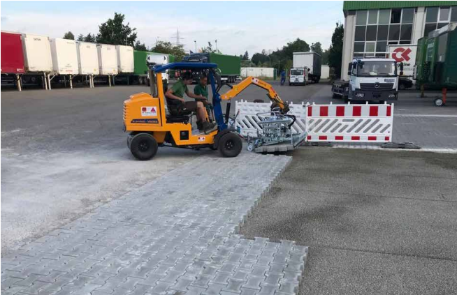
Großflächenverlegung
